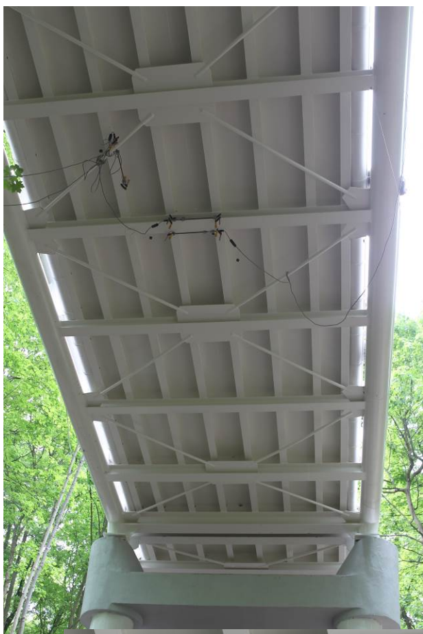
Fot.3 Ekstensometry indukcyjne związane na poprzecznicę pomostu i stężeniu do pomiaru wydłużeń
