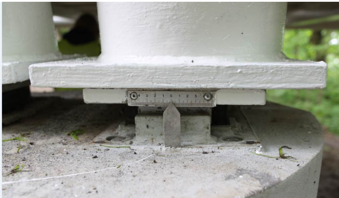
Fot.6 Odczyt przesuwu łożyska konstrukcji
