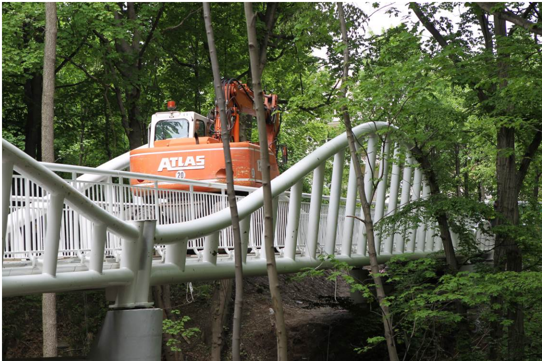
Fot.7 Statyczne obciążenie konstrukcji - ustawienie nr 1 (1 koparka na przęśle nr 3)
