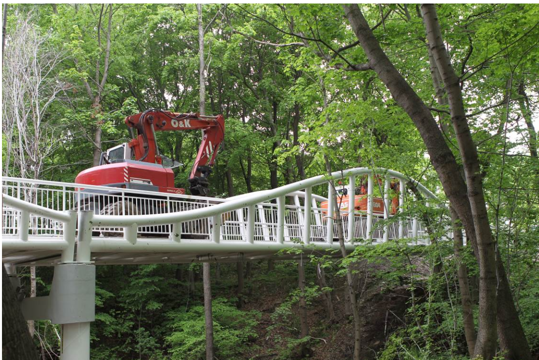
Fot.8 Statyczne obciążenie konstrukcji - ustawienie nr 2 (2 koparki na przęśle nr 3)
