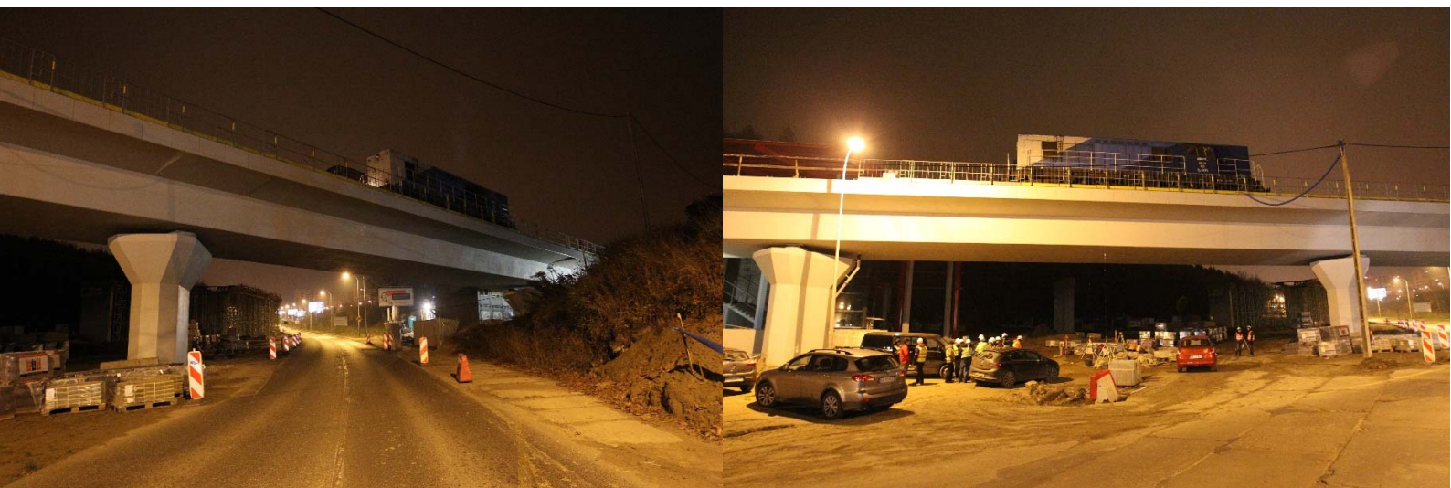
1.4. Wiadukt obciążony lokomotywami na przęsłach kolejno nr 3 i 2 , źródło [MM]
