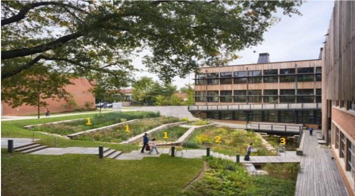
Rys. 31 System oczyszczania ścieków szarych oraz wody opadowej na dziedzińcu prywatnej szkoły Sidwell Friends w Waszyngtonie (1 – trzystopniowy system ziół hydrofitowych do oczyszczania ścieków szarych, 2 – ogród deszczowy, 3 – staw retencyjny); Źródło: http://www.archdaily.com/32490/ad-interviews-kieran-timberlake
