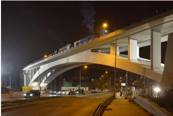
Rys. 4. Wiadukt nad ul. Słowackiego w Gdańsku w ciągu Pomorskiej Kolei Metropolitalnej zrealizowany przy współudziale pracowników Zespołu Mostów
