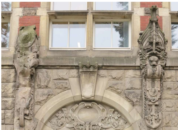
Rys. 2. Widok portalu nad prawym wejściem do Gmachu Głównego Źródło: Fot. L. Gumińska
