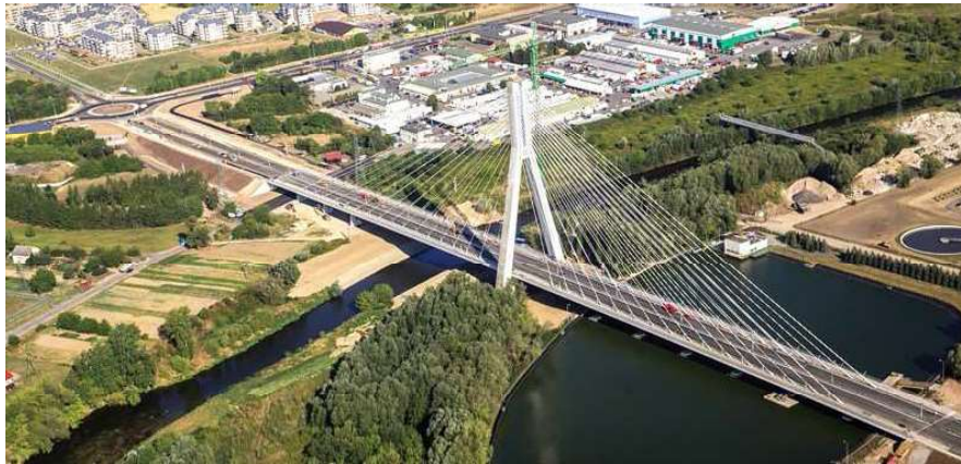
Rys. 2. Most nad rzeką Wisłok [8]
