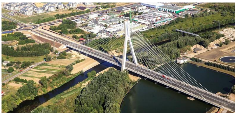
Rys. 2. Most nad rzeką Wisłok [8]
